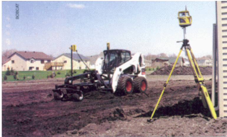
Các thiết bị laser có thể sử dụng để định hướng cho thiết bị san và đào ở gần
